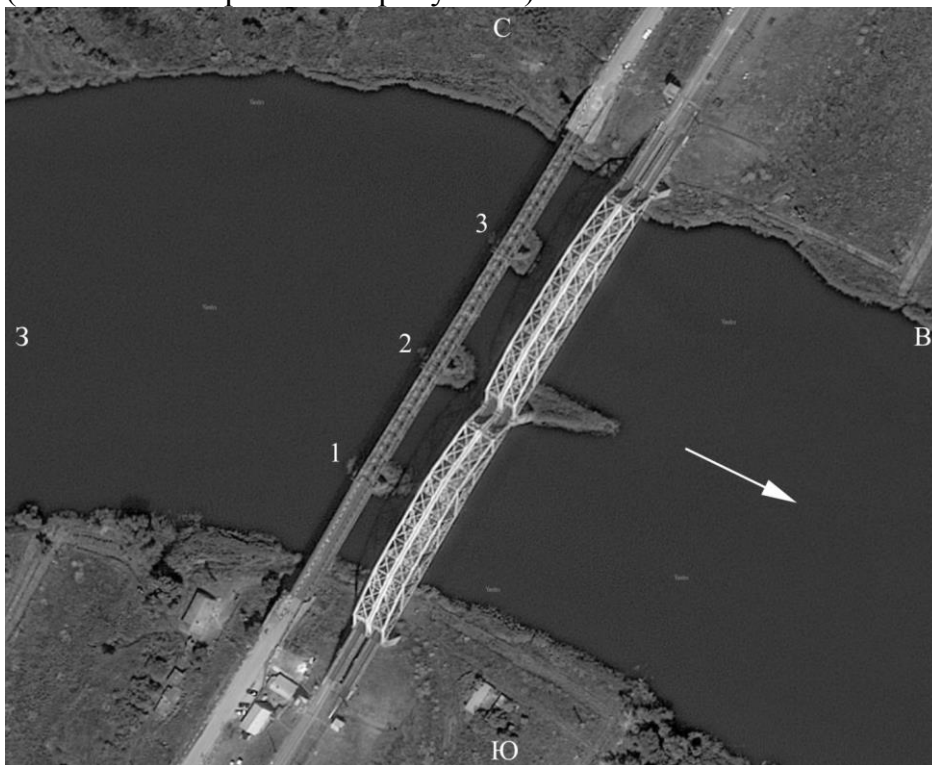
Рис. 1 – Район обследования состояния подводной части мостов
